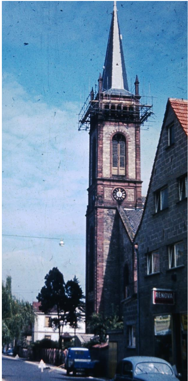
Aus dem Archiv: Foto von H.-P. Fuchs (Sohn von Pfr. Fuchs) von der Dachsanierung 1963.
